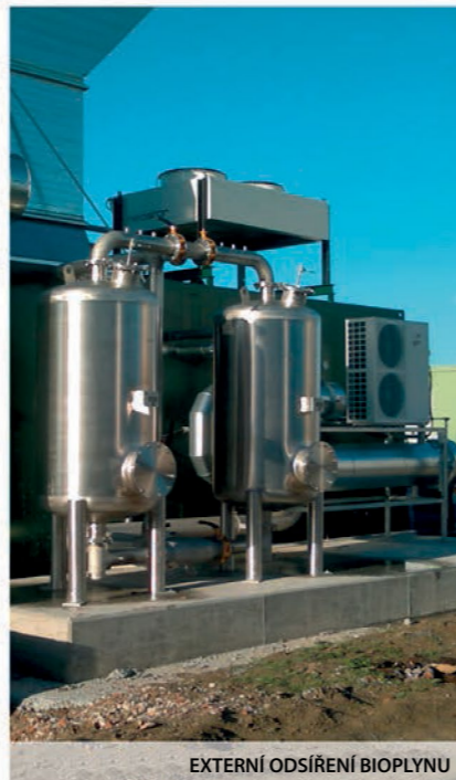
EXTERNÍ ODSÍŘENÍ BIOPLYNU
