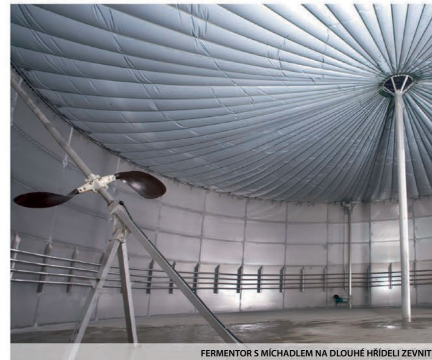
FERMENTOR S MÍCHADLEM NA DLOUHÉ HRÍDELI ZE VNITŘ
