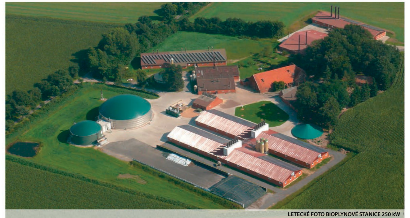
LETECKÉ FOTO BIOPLYNOVÉ STANICE 250 kW
